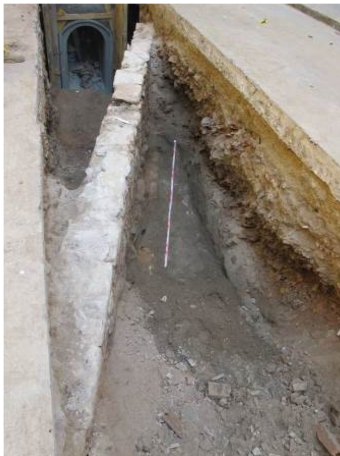
Foto 15: Mur UE 12. Costat S
