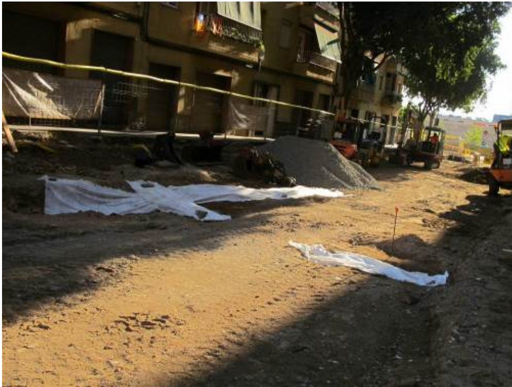
Foto 90: Cobriment de les estructures després de l'afectació parcial
