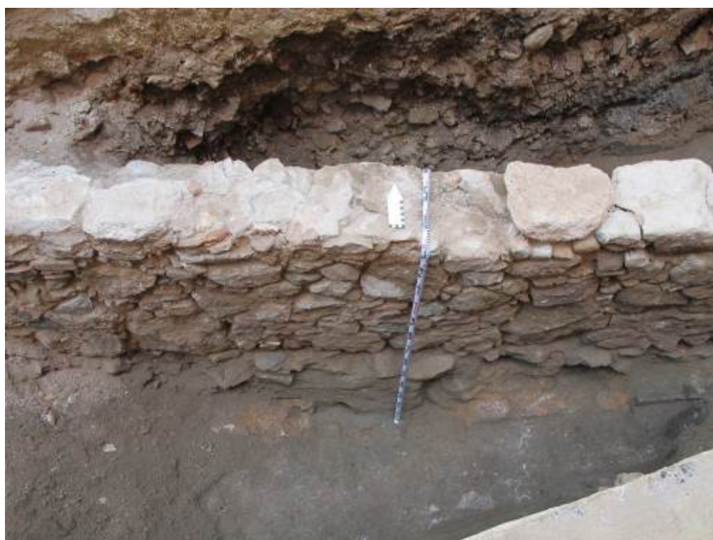
Foto 16: Murs UE 12 i UE 19. Costat S
