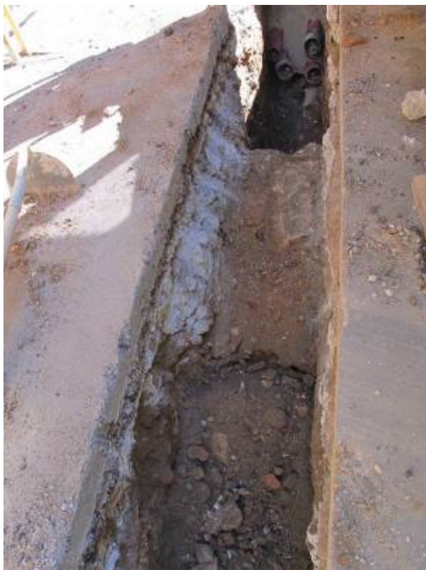
Foto 81: Tram final cruïlla amb carrer del Segre. UE 37
