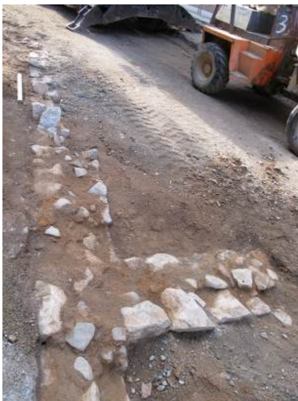
Foto 28: Murs UE 12, UE 19 i UE 20
