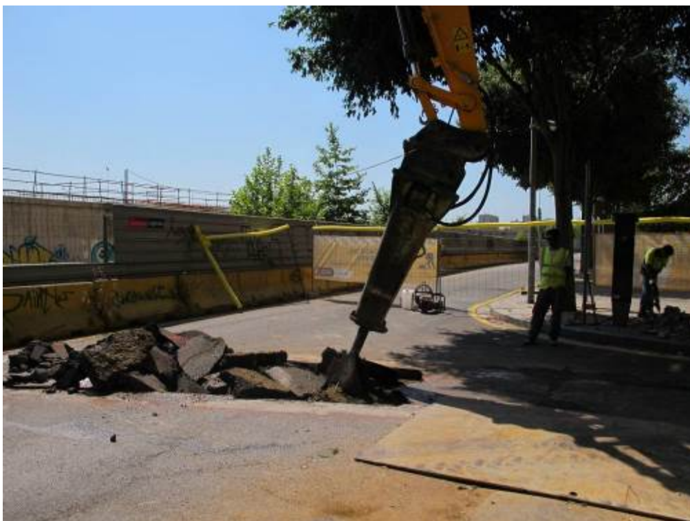
Foto 4: Inicial de la intervenció cruïlla amb carrer de Josep Soldevila
