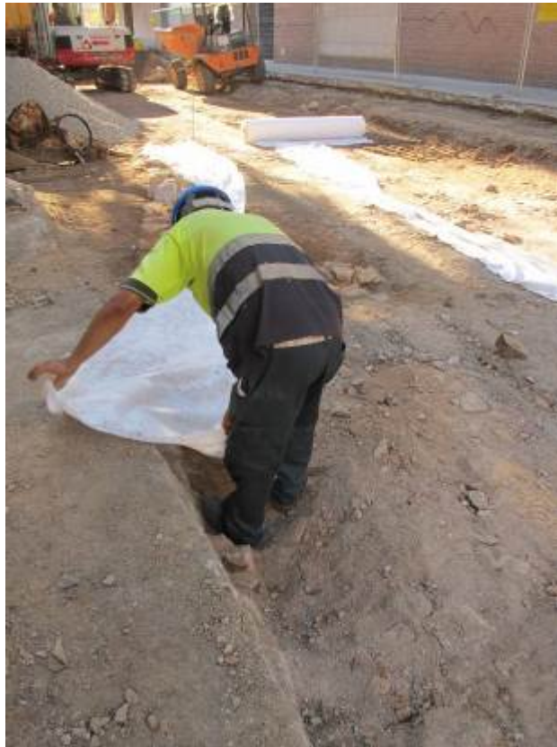
Foto 88: Cobriment de les estructures després de l'afectació parcial
