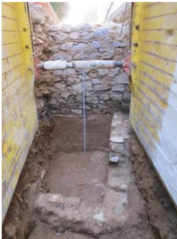
Foto 41: Alçat oest mur UE 20. Dipòsit UE 31
