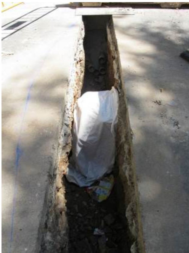
Foto 92: Cobriment de les estructures després de l'afectació parcial. E 37
