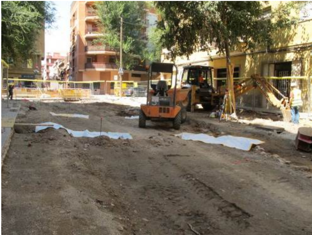
Foto 86: Cobriment de les estructures després de l'afectació parcial
